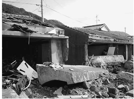
写真2 崩壊したパラペットが飛び込んだ住宅
