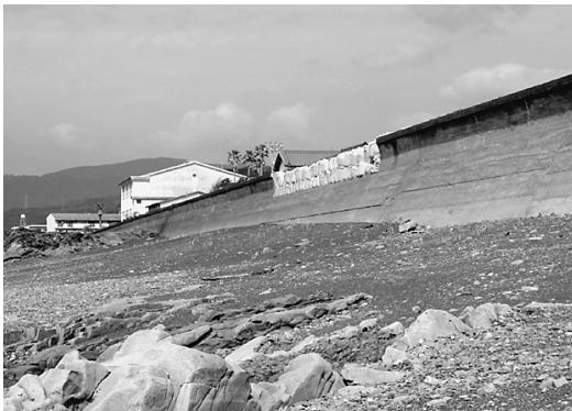
写真1 被災した防潮堤
