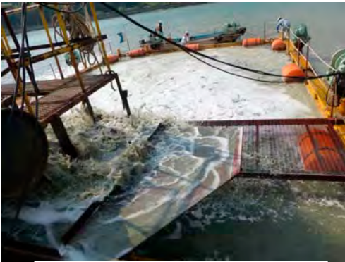
写真4 造成干潟での覆砂状況
