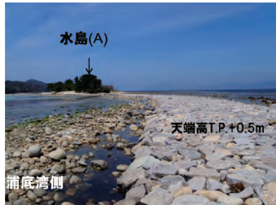
図 8 低気圧通過前後における突堤 3 付近の状況
