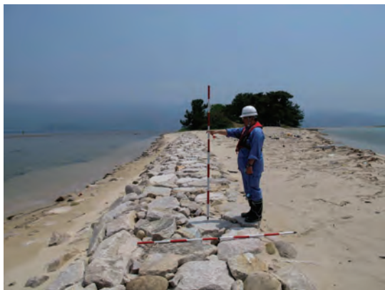
図11 新設された突堤嵩上げ工
