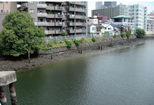
写真4 干出した浅場（朝潮運河）工事前
