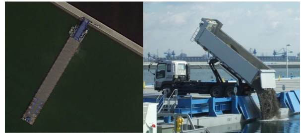
図 2.4 浮体棧橋を用いた水中埋立
