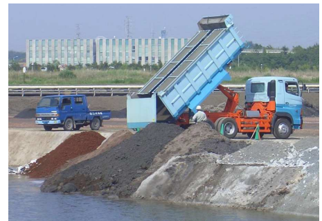
図 2.5 ダンプアップによる気中埋立
