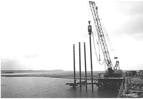
図5 杭打機による杭打設の状況
