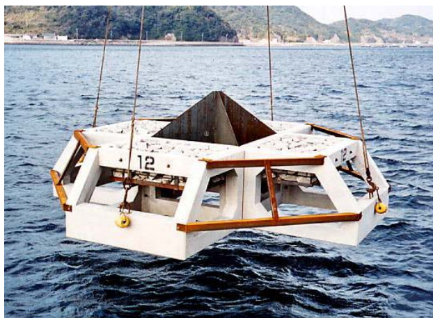
図 2.1 多孔質藻礁の沈設状況
