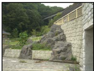
写真-14 No.6 堀内漁港
