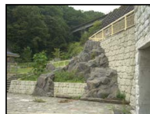
写真-14 No.6 堀内漁港
