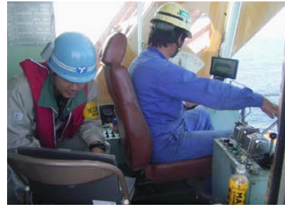
写真-2 位置決め装置のモニターを見ながら、ウィンチ速度を調整し、魚礁ブロックを沈設中
