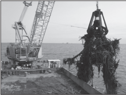
写真1 航路啓開作業（東北地方整備局資料より）
