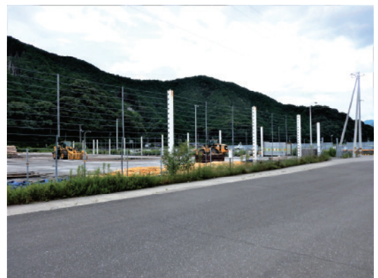
写真1 漂流物対策工例（須崎港）
